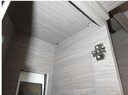
Zuerst muss die Tür ausgebaut werden. Dazu die vordere Schraube des Türscharniers etwas lösen um die Spannung aus der Halterung heraus zu nehmen und das Lösen der hinteren Schraube zu erleichtern. Mit der vorderen Schraube kann die Tür etwas nach links bzw. rechts verschoben werden. Dann die hintere Schraube soweit lösen bis die Tür nach vorne abgenommen werden kann. Die Schraube verbleibt dabei im Halter. Beginnen Sie mit dem unteren Scharnier.
