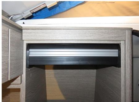
Jetzt die beiden Schienen ankleben, dabei auf 4 mm Abstand von der Vorderkante achten. Damit die Rolltür gut läuft, darf der Übergang zu den Spiralen nicht versetzt sein.
