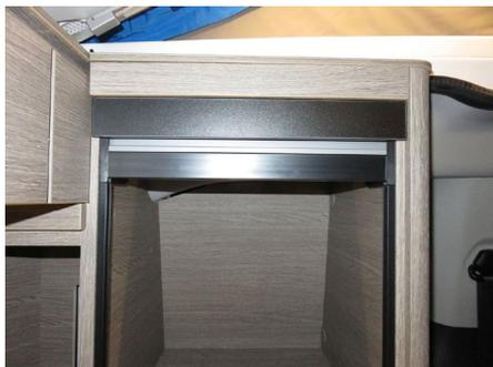
Für einen leichteren Lauf der Rolltüren bei Bedarf auch die Schienen mit etwas Silikonspray einsprühen.
