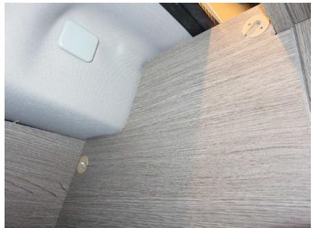
Rechts oben muss der Kunststoffeinsatz, ein sogenannter Korpusverbinder, aus der Trennwand entfernt werden um später die Kassettenspirale montieren zu können. Dieser ist nur eingesteckt. Am einfachsten geht das wenn Sie einen kleinen Schraubenzieher in das Schraubloch einsetzen und etwas hebeln. Der Schraubenzieher darf dabei nur im Kunststoffeinsatz stecken und nicht im Holz.
