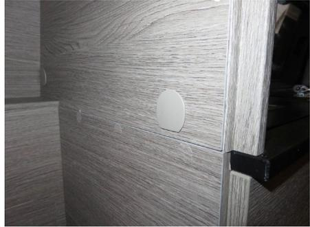
Jetzt die obere Abdeckung wieder montieren. Einfach von vorne einschieben, dabei wegen dem Winkel links anheben. Schraublöcher ggf. mit einem dünnen Draht oder sehr kleinen Inbusschlüssel suchen. Links kann man auch die Abdeckung etwas anheben, dann sieht man Schraubenspitze und Schraubloch. Nachdem die drei Schrauben angezogen sind wieder die drei Klebepunkte anbringen.
