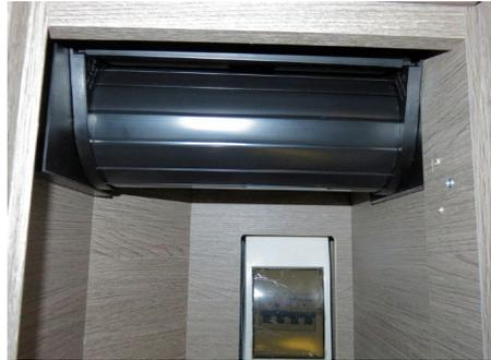
Jetzt die beiden Schienen ankleben. Auf der rechten Seite mit Hilfe der Distanzstücke auf 4 mm Abstand von der Vorderkante achten. Damit die Rolltür gut läuft, darf der Übergang zu den Spiralen nicht versetzt sein.
