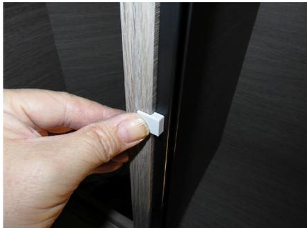
Damit die Rolltür unten zuverlässig auf der Holzleiste aufsitzt das Winkelprofil von hinten an die unterste Lamelle ankleben. Vorher die Rolltür mittig in den Schienen ausrichten.
